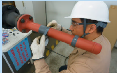
保全管理講座ピンホール修理
