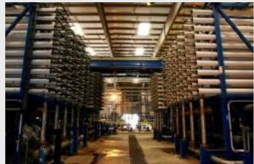
逆浸透膜エレメントを用いた海水淡水化プラント
