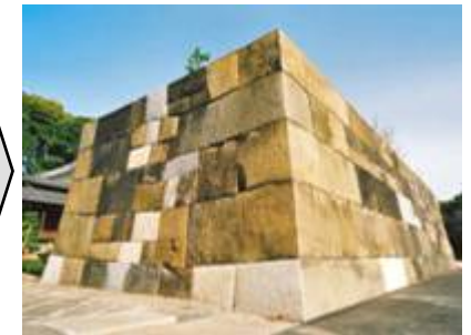
修復工事完了後
