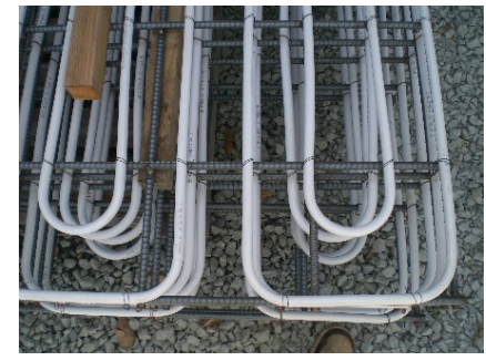
無散水融雪装置(曲げ加工部)
